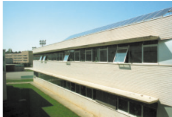
Instalación de placas solares en un colegio público.
